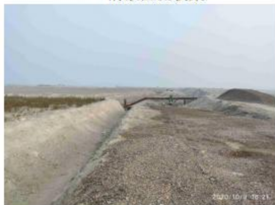
渣场渗滤及雨水的输送管线
