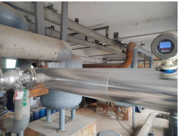
化纤公司实施远达动力一车间废气回收废水回收综合利用
